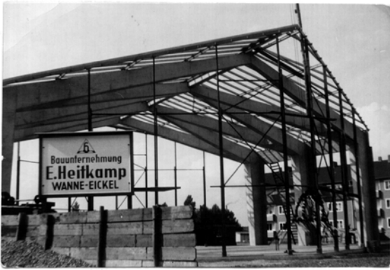
Rohbau der Stephanuskirche
